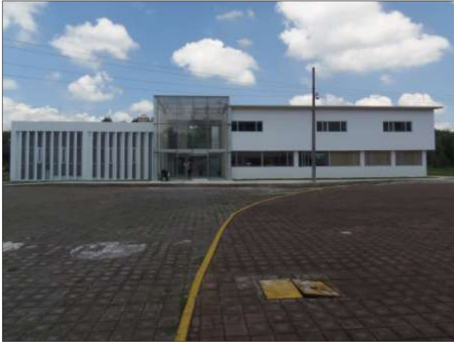
FACHADA PRINCIPAL DEL CENTRO MÉDICO.
